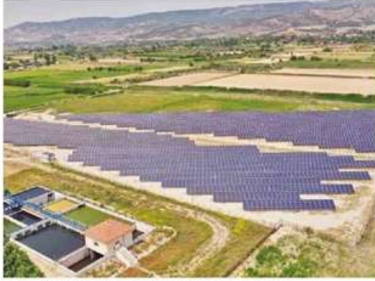
DENİZLİ BÜYÜKŞEHİR BELEDİYESİ GÜNEŞ ENERJİ SANTRALİ
